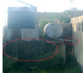
شكل (١٢): مشاكل ناتجة عن تلف عوامات الخزانات العلوية وفي غياب العزل الصحيح لأسطح المباني (الدراسة الميدانية)
