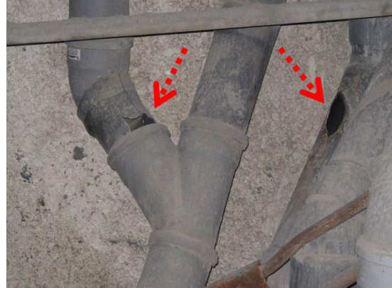
تآكل بعض الأجزاء بواسطة القوارض
