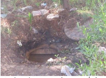
ترك أحد غرف التفتيش مفتوحة يحيط بها الطمي يعرضها للسدد
