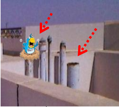
شكل (٢٠): عدم وضع أغطية علوية لمواسير الصرف يعرضها للسدد والتلف (الدراسة الميدانية)
