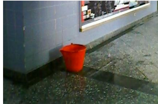
عزل فواصل التمدد بمواد لدنة عازلة للمياه تسرب مياه ناتج عن عزل سيء لفواصل تمدد بأسطح أحد المباني شكل (٢٩): التنفيذ السيء لفواصل التمدد وعدم وجود ميول وتصريف جيد بالأسطح (الدراسة الميدانية)
