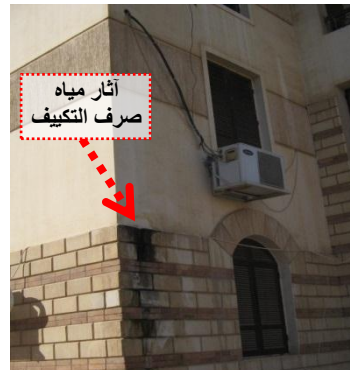
شكل (١٩): صورة تظهر تشابك وتداخل مسارات الصرف في المباني بشكل عشوائي (الدراسة الميدانية)
