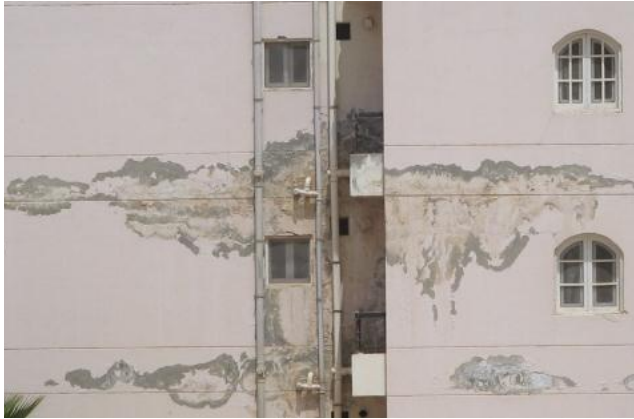
نشع بطول واجهة الدور بالكامل نتيجة تسرب المياه عبر هذه الفواصل من أرضية الحمام إلى أرضية الغرف المختلفة فاصل بين أرضية حمام وأحد الغرف تظهر به آثار الرطوبة وتسرب المياه على العلف الخشبية لأرضية الغرفة شكل (٣٠): التنفيذ السيء لعزل حواجز الأبواب بين أرضية الحمام والغرف المحيطة (الدراسة الميدانية)
