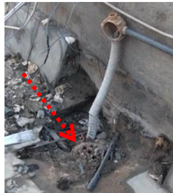
تفصيلة جرجوري السطح جرجوري منفذ بطريقة مقبولة نسبيا جرجوري منفذ بطريقة خاطئة شكل (١٥): صور تظهر الفرق بين التنفيذ السيئ لجرجوري السطح والوضع السليم (الدراسة الميدانية)
