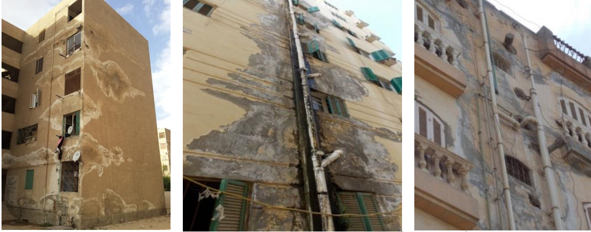
شكل (٤): تأثير مشاكل الأعمال الصحية على نهو الواجهات الخارجية للمباني (الدراسة الميدانية)
