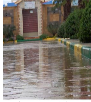
شكل (١٨): عدم وجود شبكات وميول لصرف مياه الأمطار لأعمال تنسيق الموقع (الدراسة الميدانية)
