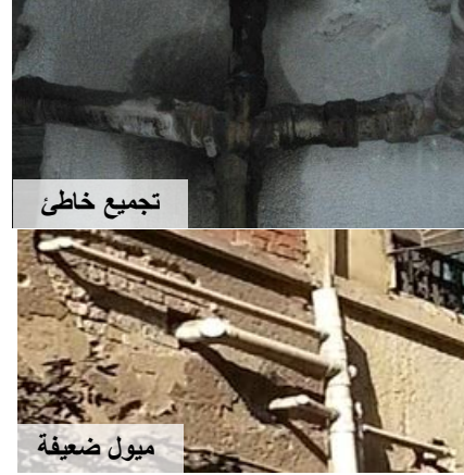
شكل (١٣): عدم وجود ميول أفقية والتجميع الخاطئ لمواسير الصرف أحد المشاكل الشائعة (الدراسة الميدانية)
