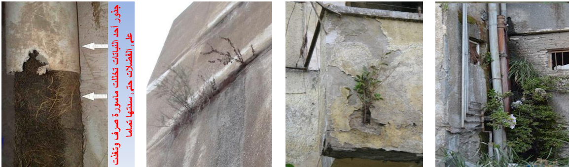
شكل (٥): تأثير مشاكل الأعمال الصحية على نهو الواجهات الخارجية للمباني، (الدراسة الميدانية) هل هذا هو مفهوم العمارة الخضراء لدى المعماريين والإنشائيين في مصر؟؟؟
