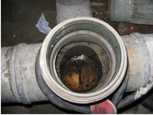
تآكل الأكواع بسبب المنظفات الكيميائية لأحد المغاسل التجارية
