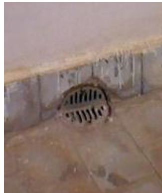
تفصيلة جرجوري السطح جرجوري منفذ بطريقة مقبولة نسبيا جرجوري منفذ بطريقة خاطئة شكل (١٥): صور تظهر الفرق بين التنفيذ السيئ لجرجوري السطح والوضع السليم (الدراسة الميدانية)
