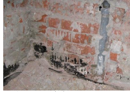
رسم يوضح الوضع الصحيح شكل (٢٨): وضع خاطئ وآخر صحيح لعلاقة مسارات الصرف بالعزل ومنسوب بلاط الأرضية (الدراسة الميدانية)
