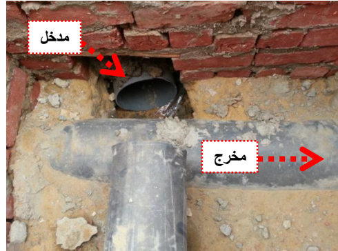
وضع خاطئ "منسوب المدخل أقل من منسوب المخرج" شكل (١٤): التنفيذ السيئ لغرف التنقيش (الدراسة الميدانية) الوضع الصحيح
