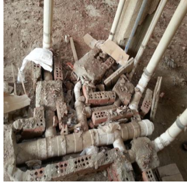
شكل (١٩): صورة تظهر تشابك وتداخل مسارات الصرف في المباني بشكل عشوائي (الدراسة الميدانية)
