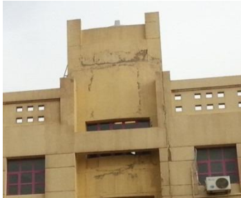
شكل (١٢): مشاكل ناتجة عن تلف عوامات الخزانات العلوية وفي غياب العزل الصحيح لأسطح المباني (الدراسة الميدانية)
