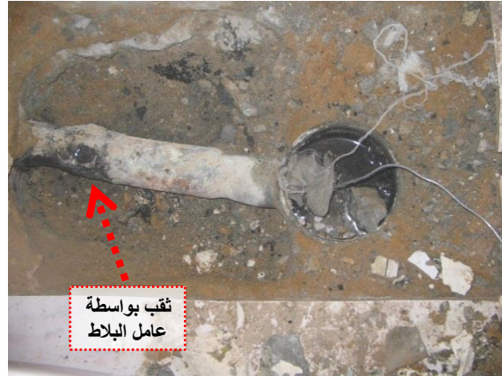
شكل (٢٢): ثقب في ماسورة صرف من الرصاص بواسطة عامل البلاط (الدراسة الميدانية)
