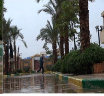
شكل (١٨): عدم وجود شبكات وميول لصرف مياه الأمطار لأعمال تنسيق الموقع (الدراسة الميدانية)
