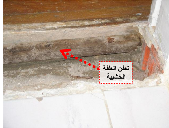
نشع بطول واجهة الدور بالكامل نتيجة تسرب المياه عبر هذه الفواصل من أرضية الحمام إلى أرضية الغرف المختلفة فاصل بين أرضية حمام وأحد الغرف تظهر به آثار الرطوبة وتسرب المياه على العلف الخشبية لأرضية الغرفة شكل (٣٠): التنفيذ السيء لعزل حواجز الأبواب بين أرضية الحمام والغرف المحيطة (الدراسة الميدانية)
