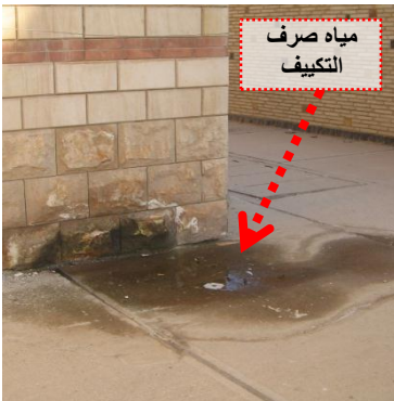
شكل (٢٠): عدم وضع أغطية علوية لمواسير الصرف يعرضها للسدد والتلف (الدراسة الميدانية)
