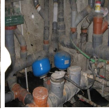
شكل (١٩): صورة تظهر تشابك وتداخل مسارات الصرف في المباني بشكل عشوائي (الدراسة الميدانية)
