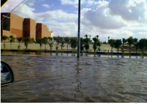
شكل (١٨): عدم وجود شبكات وميول لصرف مياه الأمطار لأعمال تنسيق الموقع (الدراسة الميدانية)
